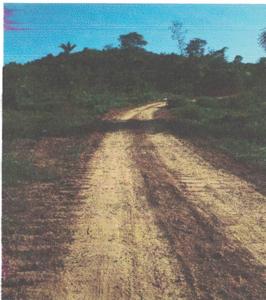
Faze B. de Bueiro. Elevar o Aterro. 4°18'39.84"S 56°11'50.07"O
